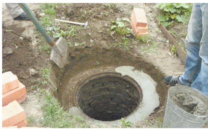
Вот на такую глубину люк был засыпан, пришлось поднимать
