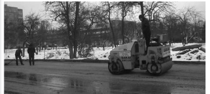
Возле магазина «Орёл» дорожные работы активизировались 5 декабря по снежку
