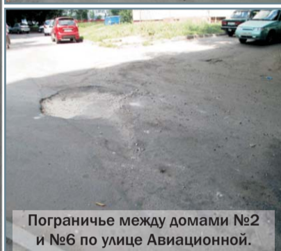
Внутридворовой проезд возле дома по Авиационной, 6.
